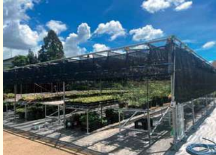
府中市の新設した作業場
