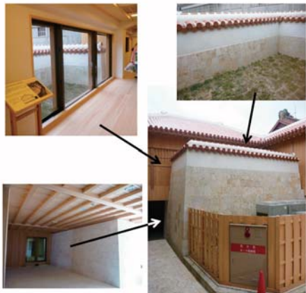
首里城の人工地盤緑化
