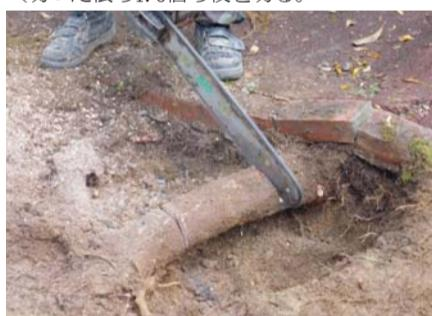
③切断した根を上から下へ斜めに切断。
