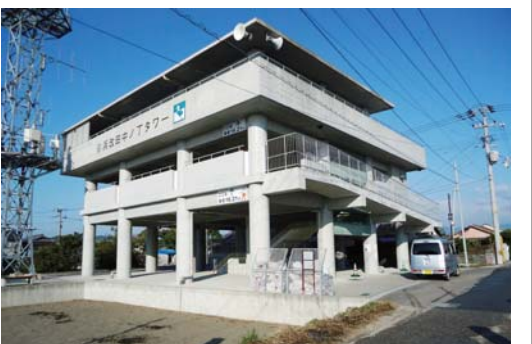
整備が進む津波避難タワー
