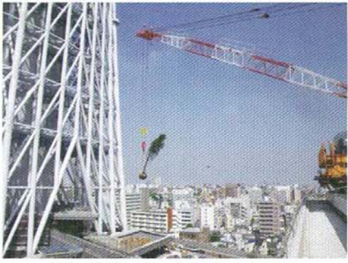
ツリー脇をクレーンで移動する樹木
